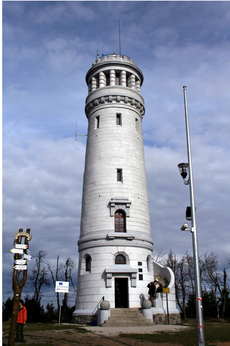
Wieża widokowa na Wielkiej Sowie 30
