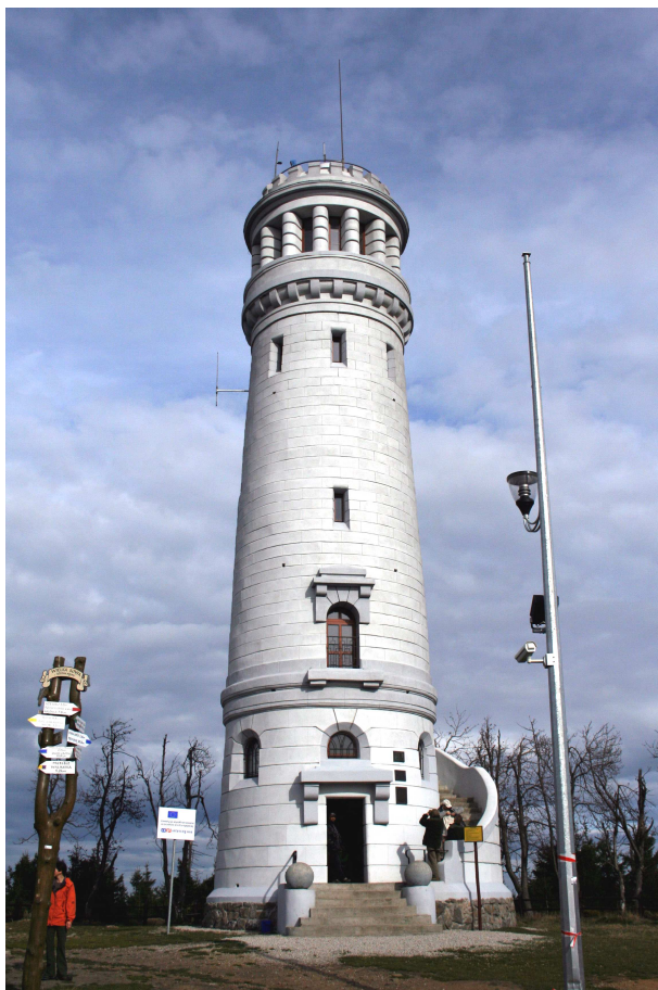
Rys. 8 Wieża widokowa na Wielkiej Sowie (Fot. Wikipedia.pl)
